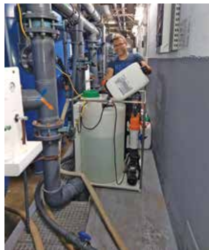
◆ SPULMOBILE W TRAKCIE REGENERACJI OKSYDACYJNEJ ZŁOŻA FILTRÓW
