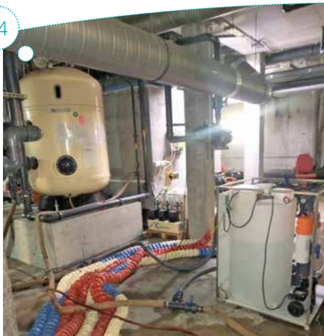
FOT. 1 PROCES OKSYDACYJNEJ REGENERACJI ZŁOŻA W FILTRACH
