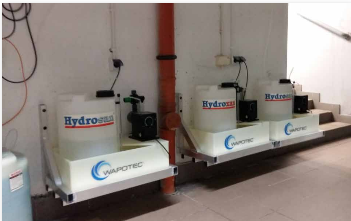
Urządzenia dozujące środki w technologii WAPOTEC®SYSTEM
