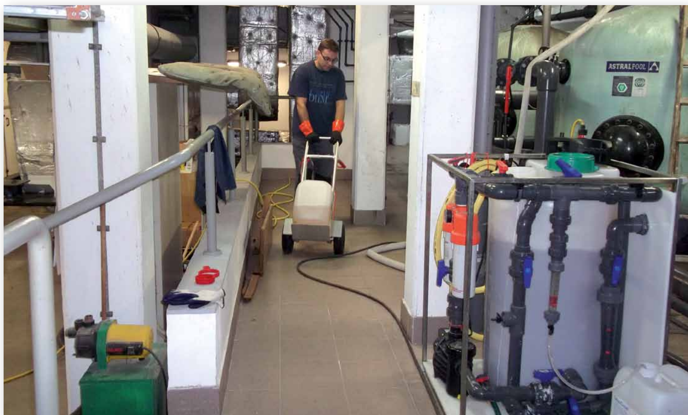
Praca Spulmobila w trakcie regeneracji złożeń w filtrze metodą DesoPur
