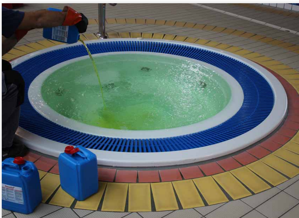
Rozprowadzanie na powierzchni wody wyliczonej ilości roztworu z pakietu LegioCid® PLUS Pakiet
