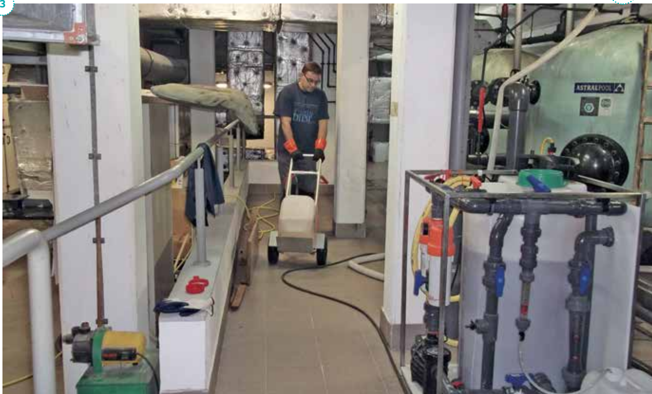
◆ REGENERACJA ZŁOŻA WG DESOPUR Z WYKORZYSTANIEM SPULMOBILE
