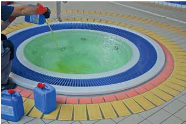
◆ ROZPROWADZANIE NA POWIERZCHNI WODY WYLICZONEJ ILOŚCI ROZTWORU Z PAKIETU „LEGIOCID® PLUS PAKIET”
