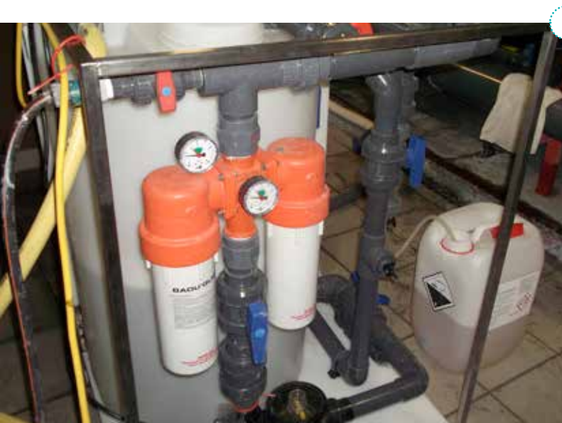
♦ URZĄDZENIA SPULMOBILE DO „CZYSZCZENIA” ZŁOŻA FILTRACYJNEGO METODĄ DESOPUR ®
