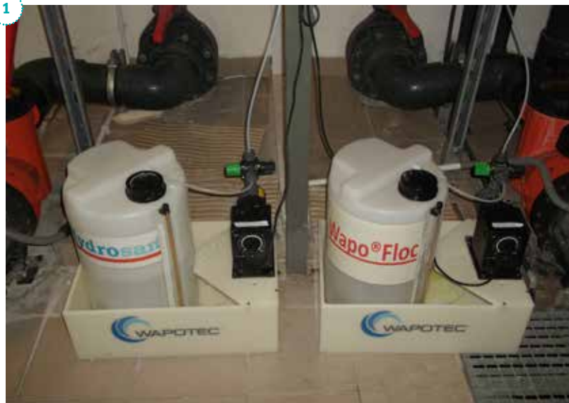
AQUAPARK OSTRÓDA – UKŁAD DOZOWANIA HYDROSAN® I WAPOFLOC®
